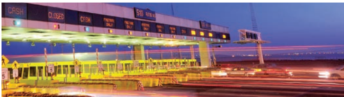
Casetas del Puente de la Bahía San Francisco-Oakland
