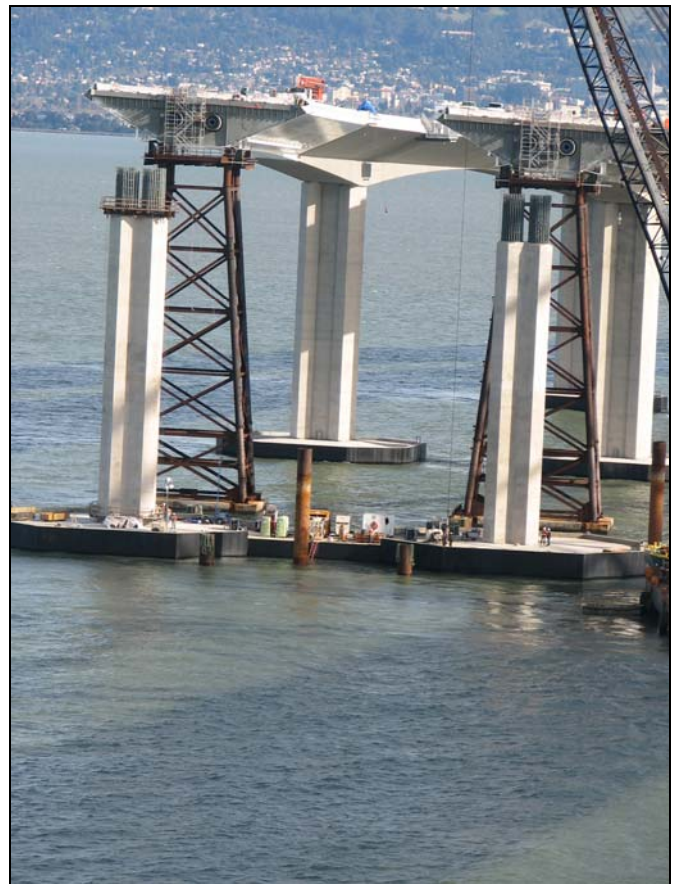
E2-T1 - Completed E2 Columns
