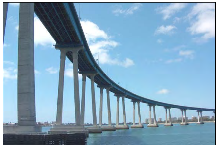
San Diego-Coronado Bridge
