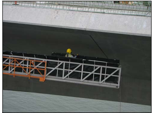
Sandblasting Soffit
