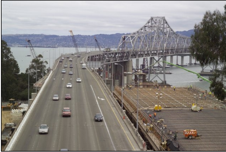
East Span Pour for Tie-in
