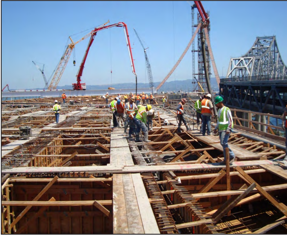
Yerba Buena Island Transition Structures #1 Westbound Concrete Pour
