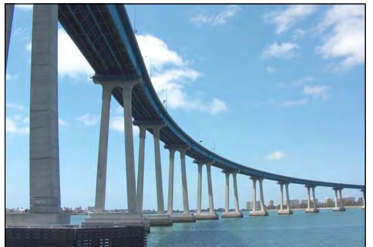
San Diego-Coronado Bridge
