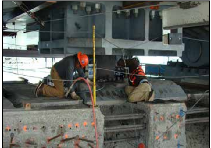
Detensioning E2E Shear Key Bolts
