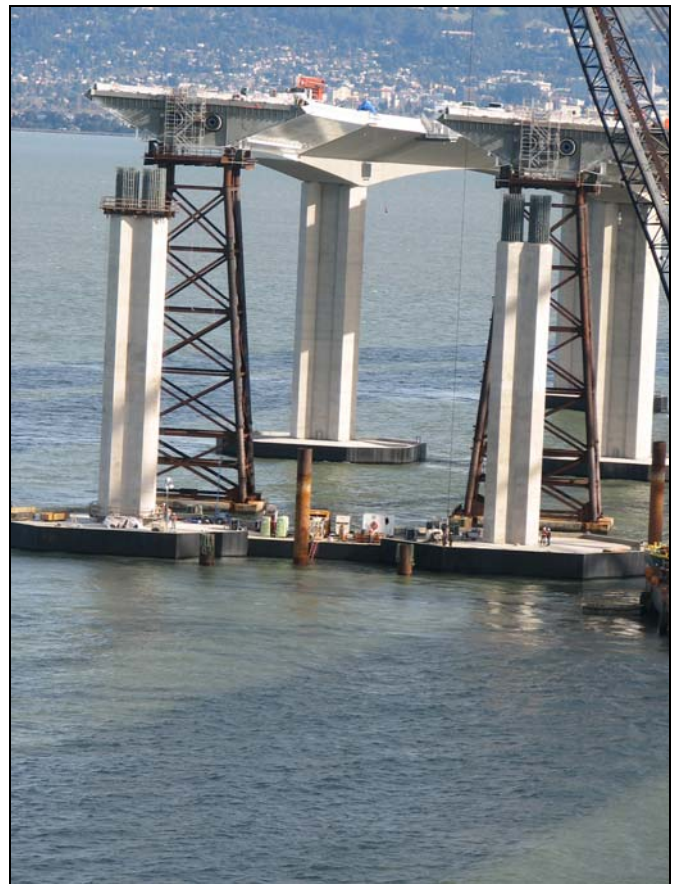
E2-T1 - Completed E2 Columns
