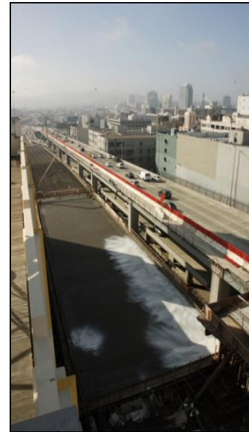
West Approach Concrete Pour
