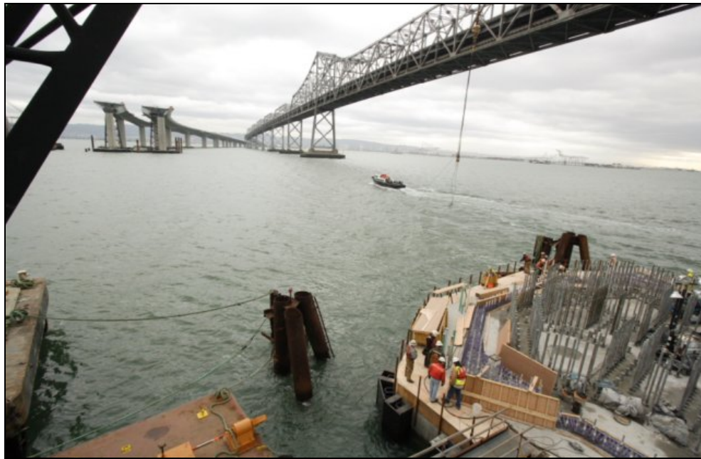
East Span Footing Pour at T1
