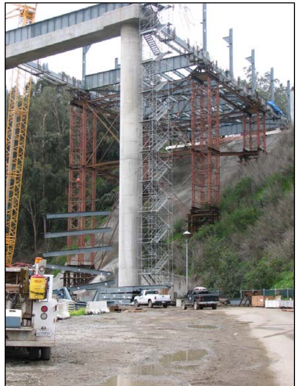
YBID - Detour Viaduct Erection
